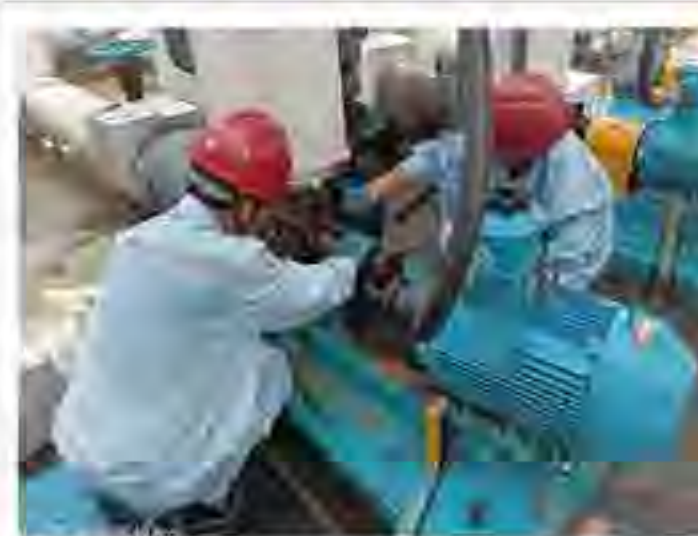
主题：为安全，不惧汗流浹背 时间：8月17日 地点：生产装置一期制氢 说明：运行保障部的燕师傅和李师傅身着浅蓝色工装正蹲姿协作维修一期制氢导热油泵，两人佩戴防护手套，专注于设备轴承部位操作。一人手持工具调整部件，另一人辅助配合，及时消除泵的异常情况，保障生产的正常运行。
