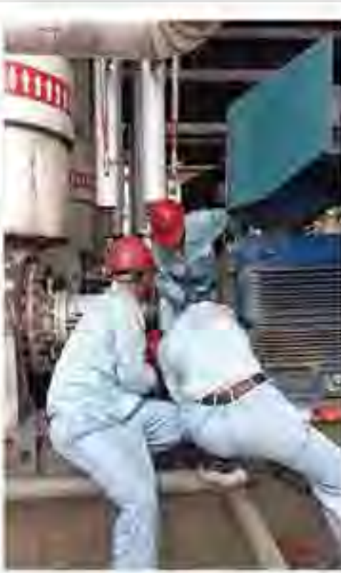
主题：未雨绸缪定海针 时间：8月11日 地点：动力保障车间1号导热油泵 说明：运行保障部维修班郭洵淘、张新华、燕勤江，对动力保障车间1号导热油泵进行了维修，由于技术要求高，工作量大，天气炎热，直到下午18点以后加班修复完成，中班21点40分，4号导热油泵突然停运损坏，1号导热油泵及时投入，未雨绸缪，为稳定生产起到了关键作用。
